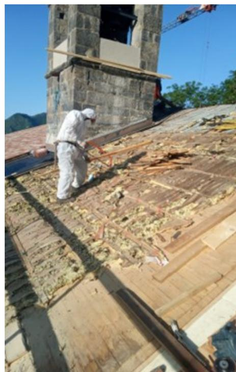
*Rimozione detriti e vecchie coibentazioni sottostanti le lastre in fibrocemento.*
