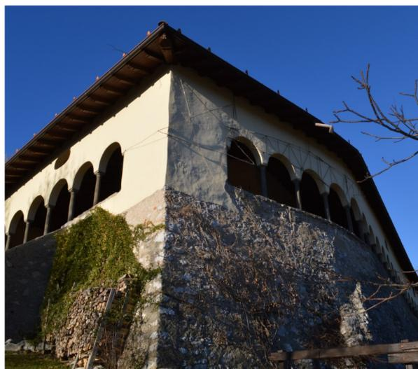
venire sul campanile data la presenza di depositi carboniosi e di biodeteriogeni sugli elementi lapidei. Questi ultimi, una volta eliminate le tracce di alterazione di cui sopra, potranno restituire un'immagine completamente diversa rispetto all'attuale e del tutto simile all'originale data la buona integrità dei conci che non denotano gravi segni di incoerenze, disgregazioni o disconnessioni superficiali.
